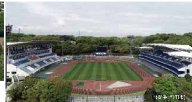
改修後の野津田競技場
